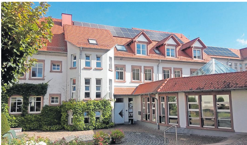
Solarzellen auf dem Dach des Verbandsgemeinderathauses
