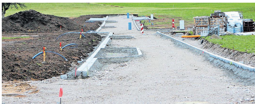
Erschließung von Neubaugebieten: Bauarbeiten und Verwaltungsaufwand
