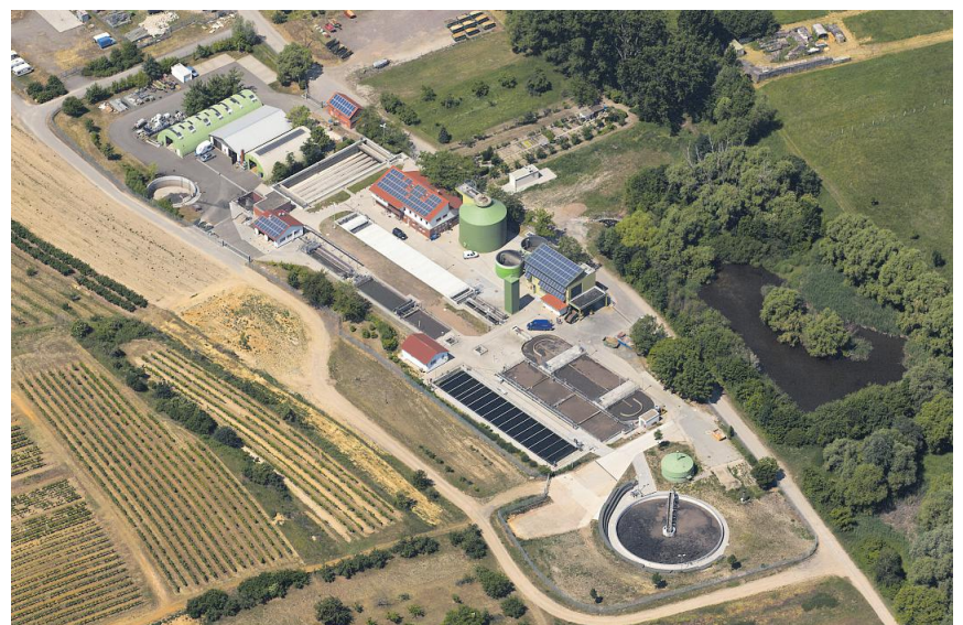
Kläranlage Weisenheim/Sand mit mechanischer und biologischer Reinigung.
