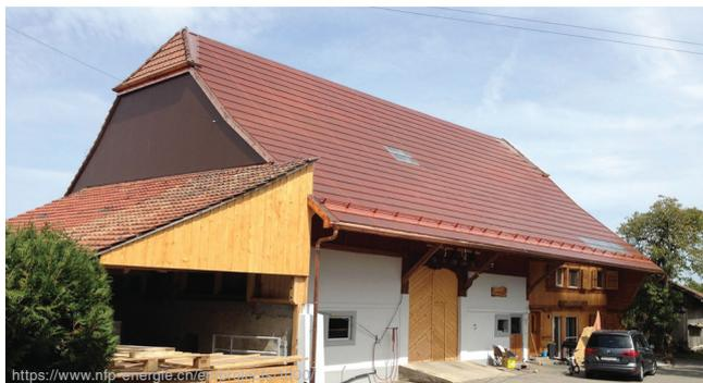
in die Dachflächen integrierte, rotbraune Solarziegel
