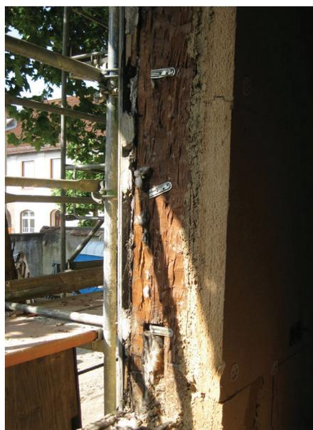
Hier: Holzfaserdämmplatten innen auf einer Fachwerkwand
